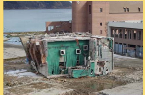
Schadensbild mit umgestürztem Gebäude in Ingagawa Foto: © N. Goseberg
